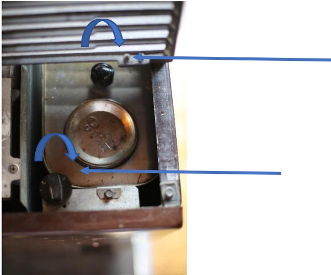
2. Remplir le réservoir à mazout jusqu'à environ 2cm du haut
