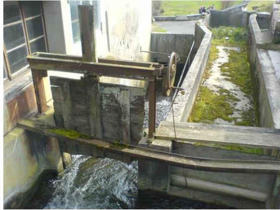
Le site du « Moulinet » est un exemple des anciennes installations utilisées par des roues à aube datant de la fin des années 1800. Ces roues étaient couplées à un axe qui entraînait des machines mécaniques, dans le cas du Moulinet il y avait un moulin à grains et à huile. Dans les années 1950 certaines roues ont été échangées contre des turbines hydrauliques couplées à des moteurs électriques pour les besoins locaux d'électrification.
